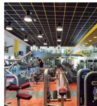
Lo + Fit Galapagar Gym. Madrid, Spain. VRF, PACi, AHU
